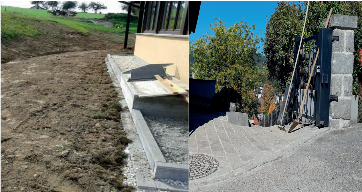
Bild 4 links: Beispiel einer gemeinschaftlichen (Geländekorrektur) und privaten (Lichtschtachthochziehen), überflutungssicheren Bauausführung; rechts: Geländekorrektur bei Eingang (Quelle: Elementarschaden Präventionszentrum – Hans Starl 2020)
