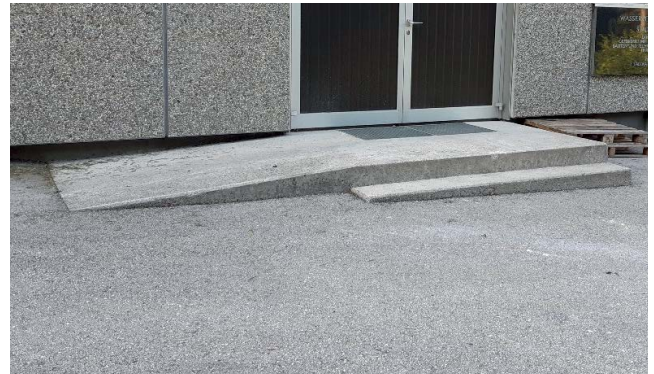
Abbildung 27: Höher gelegter Eingang schützt vor Wassereintritt.
