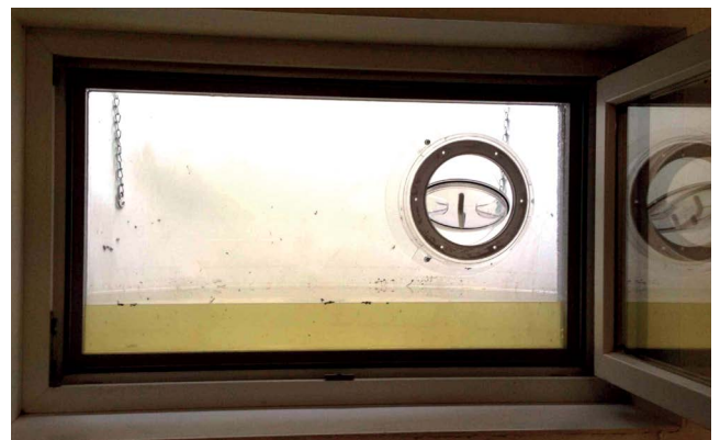
Abbildung 35: Fensterschott mit Lüftungsöffnung.
