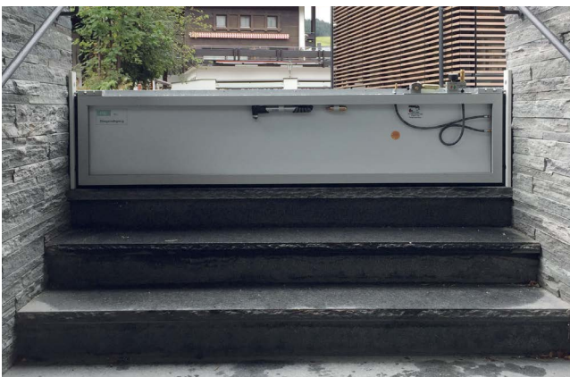
Abbildung 32: Mobiler Plattenverschluss. Aber Vorsicht: Starkregenereignisse kommen plötzlich und unerwartet. Alles sollte griffbereit sein, um rechtzeitig reagieren zu können.
