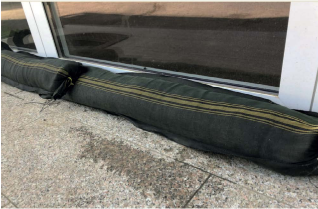
Abbildung 31: Vorgefüllte Sandsäcke bieten bei geringen Wasserständen guten und preiswerten Schutz.
