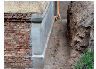
Abbildung 63: Nachträgliche Abdichtung mit wasserdichtem Sperrputz.
