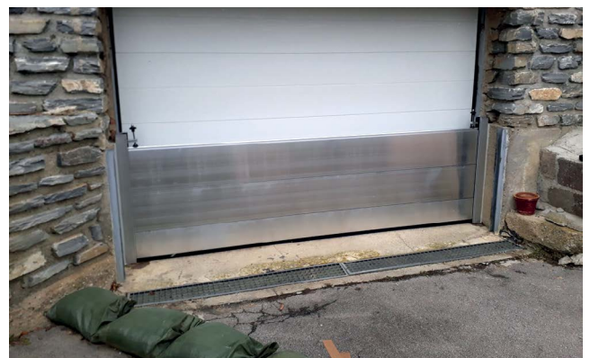
Abbildung 37: Mobiles Dammbalkensystem am Garagentor.
