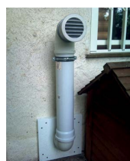
Lüftungsöffnung über Hochwasserniveau
