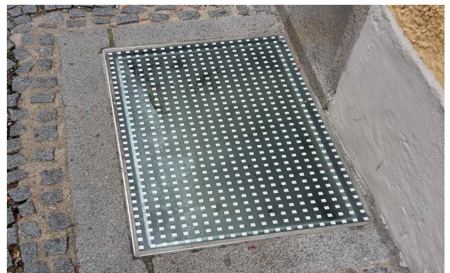
Abbildung 36: Abgedichteter Lichtschacht.
