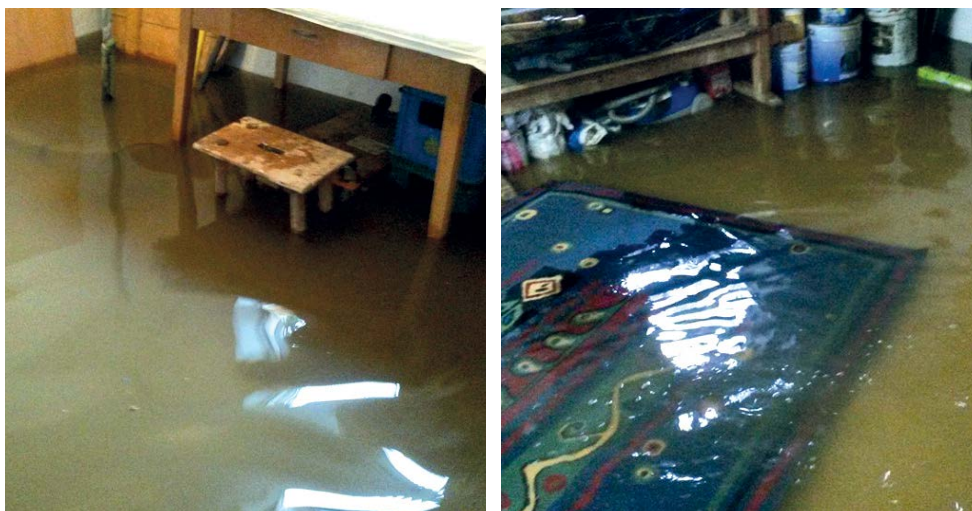
Abbildung 55: Wasser, das bei Starkregen in Keller eindringt, steht oft nur wenige Zentimeter hoch. Dennoch verursacht es oft beträchtliche Schäden. Weiß man um das Risiko, sollte man nur wasserunempfindliche Gegenstände im Gefahrenbereich lagern.
