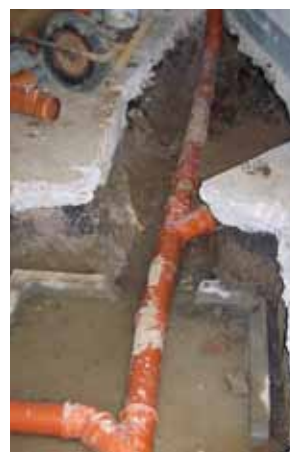
Erneuerung in offener Bauweise
