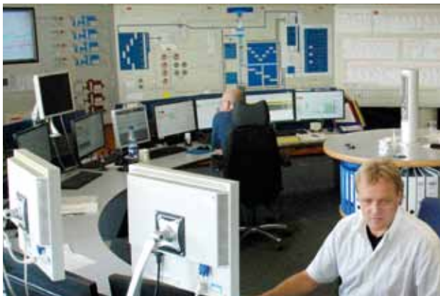
Bei Starkregen wird automatisch das Stauraumvolumen aktiviert. hanseWasser-Mitarbeiter überwachen das Kanalnetz 24 Stunden am Tag, 365 Tage im Jahr.
