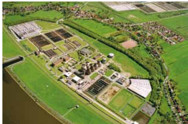
Die Kläranlage Bremen-Seehausen.
