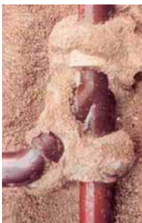
Reparatur kleinerer Schäden durch Flutungsverfahren
