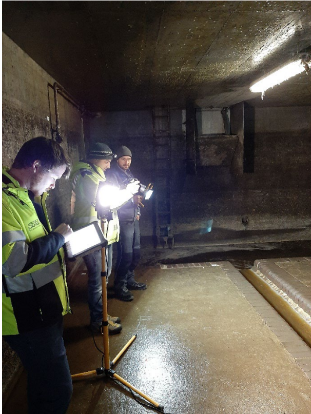
Abbildung 41: Inspektion mit Photogrammetrie, AWV Großsache Nord
