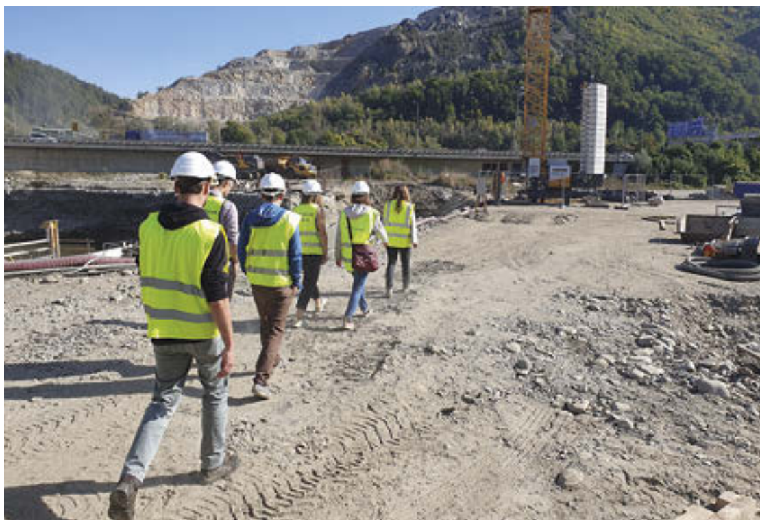
Die Junge Wasserwirtschaft bei der Exkursion zur Baustelle des Laufkraftwerks Gratkorn
