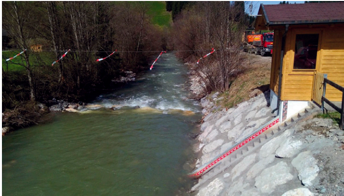
Abb. 2.24 Beispiel einer Pegelstation: Unterwindau/Windauer Ache, Tirol (Foto: HD Tirol)
