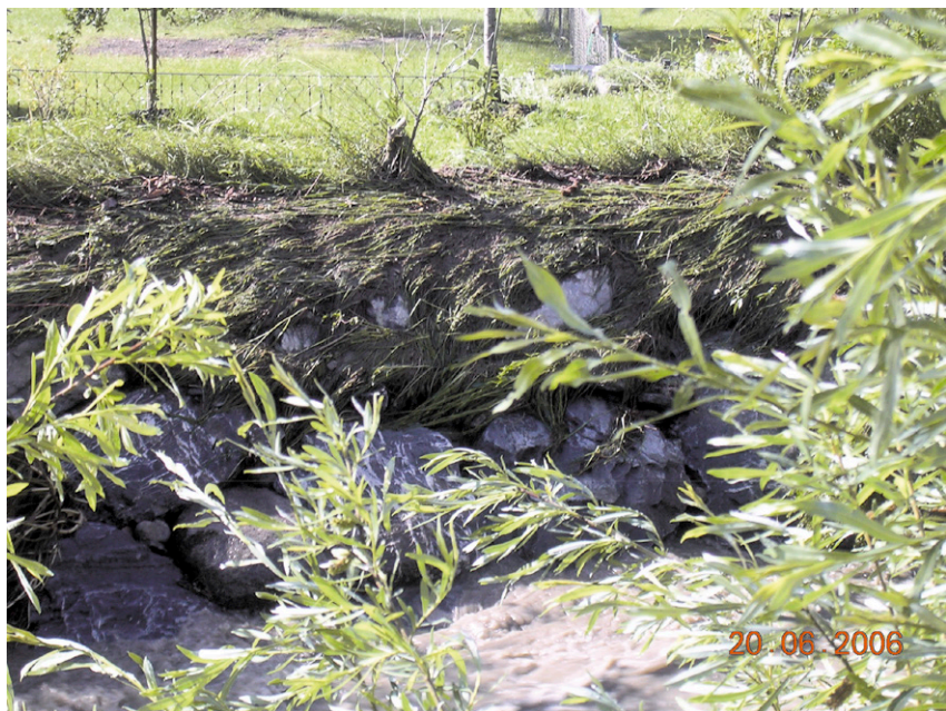
Abb. 12 Abflussmarken des Angerbaches im Ortsteil Anger, Bad Hofgastein
