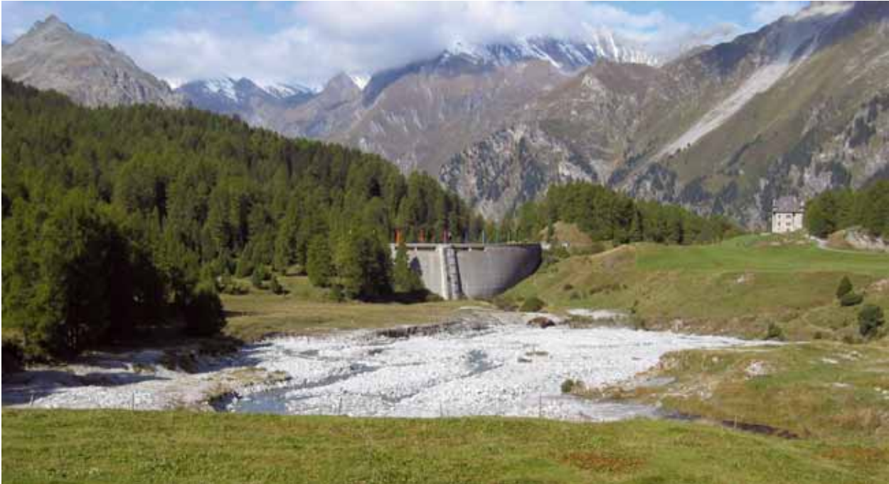
Abb. 6: Die Hochwasserrückhalteanlage Orden (bei Maloja im Oberengadin) schützt das Bergell vor Hochwasser und Murgängen, die der Orlegna-Bach aus dem Fornotal mit sich bringt. Die Mauer ist 43 m hoch, die Dammkrone 171 m lang und das Rückhaltevolumen beträgt 1.7 Mio. m 3 . Mit dem Rückgang der Gletscher und dem Auftauen von Permafrost wird das Feststoffpotenzial im Fornotal zunehmen. Das Rückhaltebecken wird in Zukunft eine zunehmende Bedeutung für den Geschieberückhalt haben.
