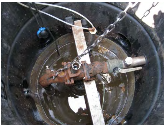
Abbildung 8-4: Pumpstation für Einzelobjekte
