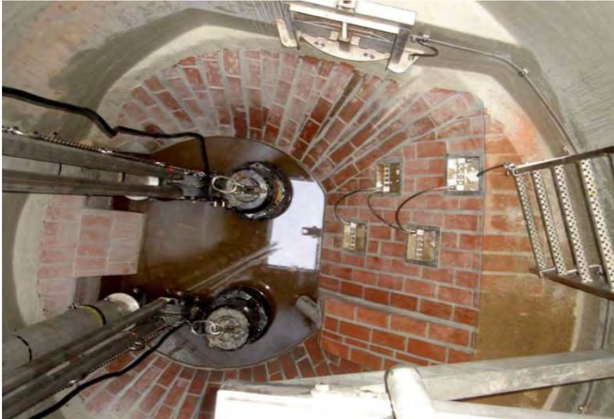
Abbildung 9-12 – Pumpensumpf nach Adaptierung (TORNOW, 2010)
