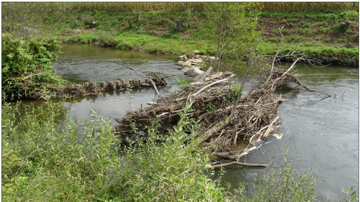
Abbildung 4: Raubäume und Holzpilotenreihen als „Totholzfänger“, © Ursula Suppan, A14, Amt d. Stmk. L.Reg., 16.09.2020
