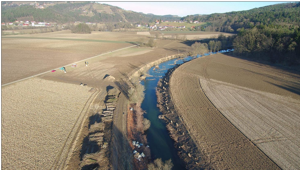
Abbildung 1: Baufortschritt aus der Luft, Zwischenlagerung der Gehölze für die „Biogene maschinelle Ufersicherung (BMU)“ vorne links im Bild, © Hans Ljubic, 02.02.2020
