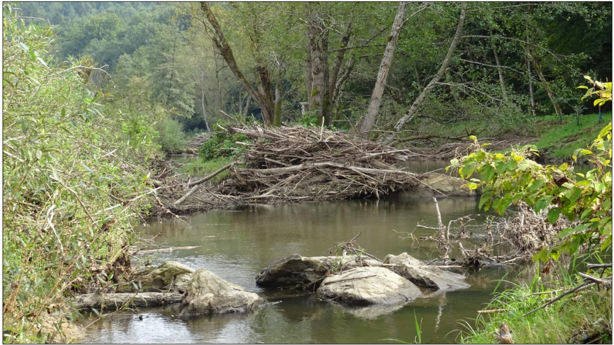
Abbildung 5: Raubaum mit Wasserbausteinen befestigt, kleine Inseln (Teile des ehemaligen Ufers) mit angeschwemmtem Totholz, © Ursula Suppan, A14, Amt d. Stmk. L.Reg., 16.09.2020
