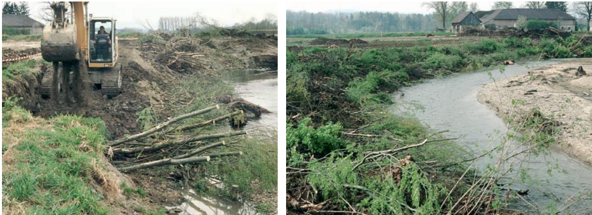
Abbildung 16: Maschinelles Einlegen von Totholz und ausschlagfähigen Gehölzen (Verein für Ingenieurbiologie 2009)
