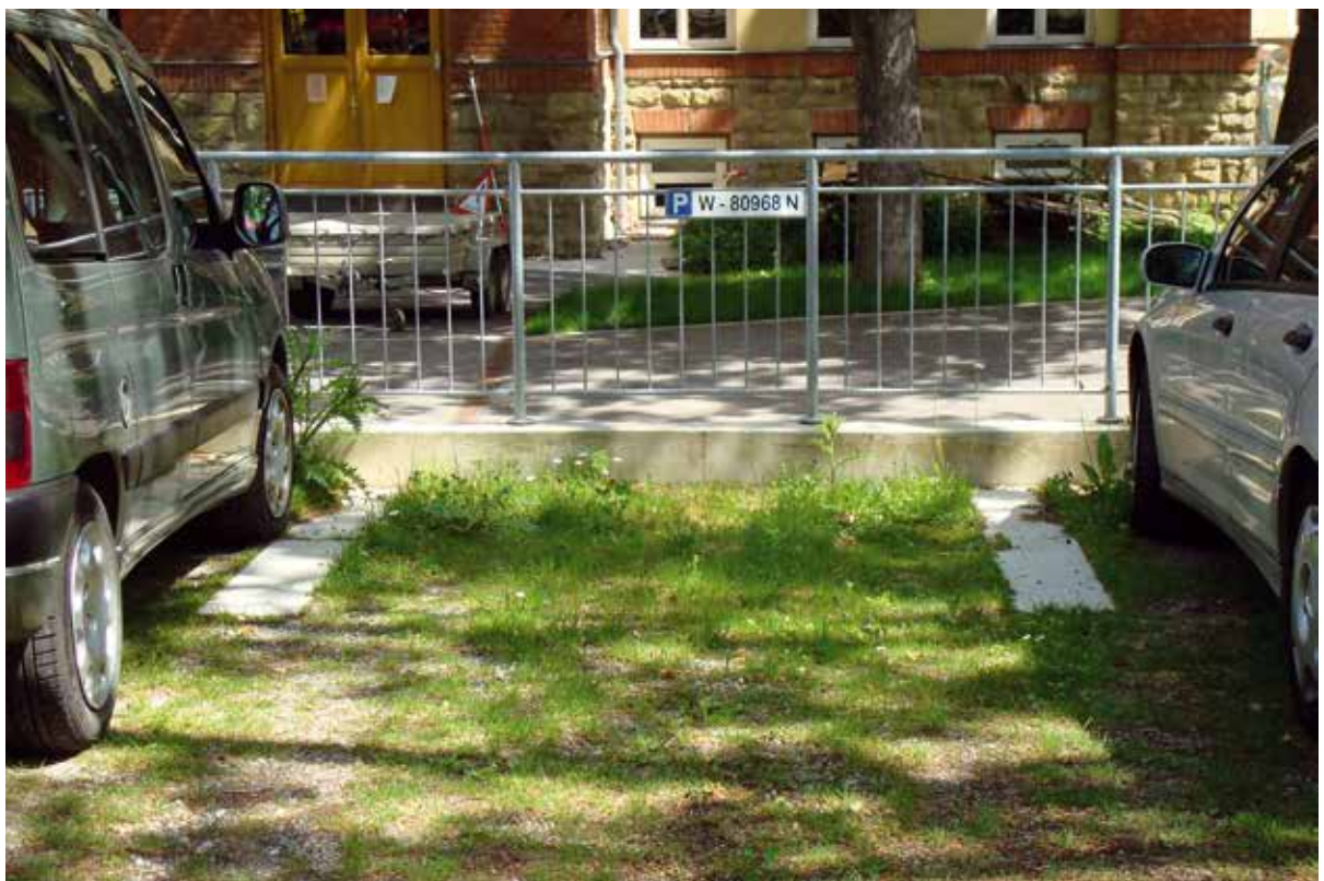
Abb. 9 Schotterrasen als begrünte, trag- und versickerungsfähige Alternative zu asphaltierten Parkplätzen, Universität für Bodenkultur Wien, 2010
