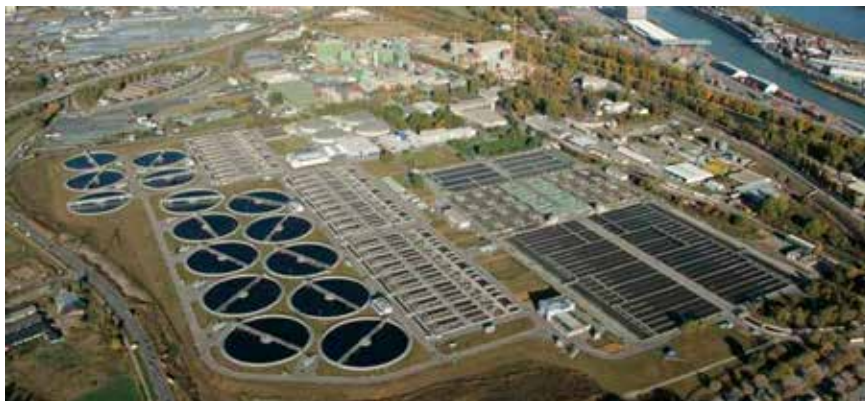
Abb. 1 Hauptkläranlage Wien – Fertigstellung Erweiterung 2005
