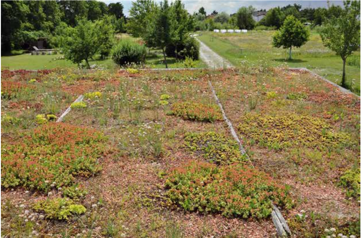
Abb. 8 Detail der Dachbegrünung eines Geräteschuppens im Versuchsgarten Wien-Essling, 2012
