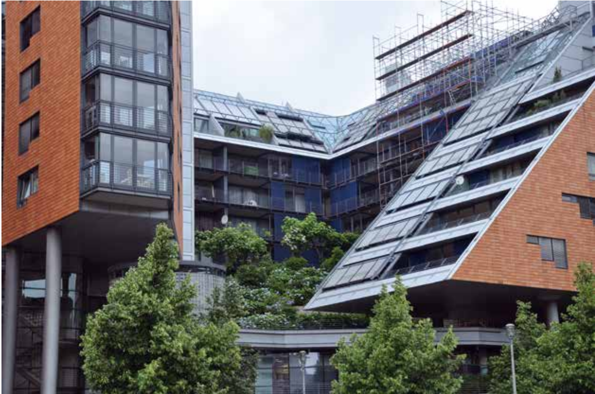
Abb. 6 Terrassenbegrünung mit Gehölzen in Berlin, 2013
