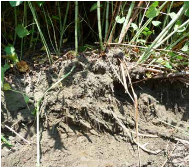
Wurzelgeflecht in einer Flussböschung
