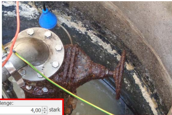
Abbildung 24: Stark korrodierter Schieber (links) und Anhaftende Stoffe (rechts).
