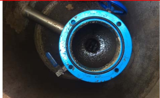
Abbildung 25: Inventarisierung und Darstellung des Bauwerkes sowie Verschmutzung und undichte Teile eines Be- und Entlüftungsventils.
