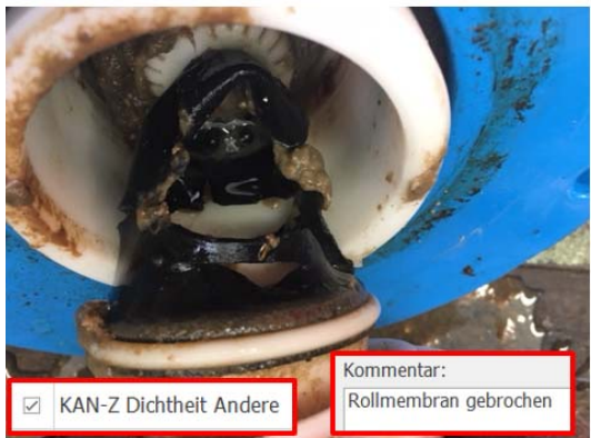
Abbildung 25: Inventarisierung und Darstellung des Bauwerkes sowie Verschmutzung und undichte Teile eines Be- und Entlüftungsventils.
