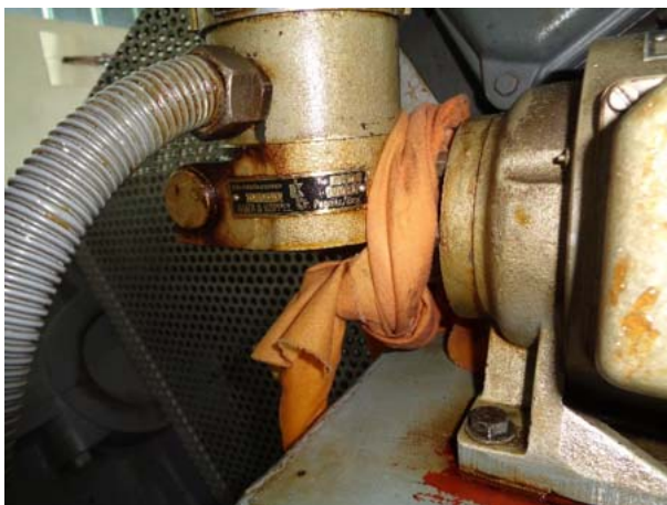
Abbildung 14: Schmierstoffaustritt bei einer Schneckenpumpe und dessen Zustandserfassung.
