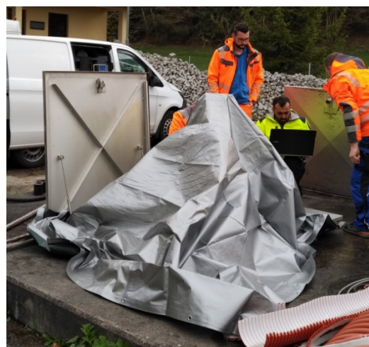
Abbildung 26: Aufstellung der CleverScan mit einer Holzlatte (links) und einer großen Abdeckplane (rechts).
