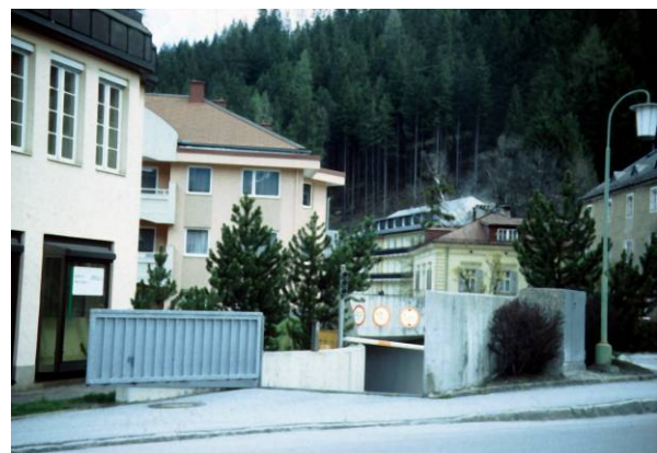
Abb. 5.8: Einfahrt einer Tiefgarage, die durch ein Schwenktor gegen Wassereintritt gesichert werden kann (Quelle: die.wildbach); aus [9]
