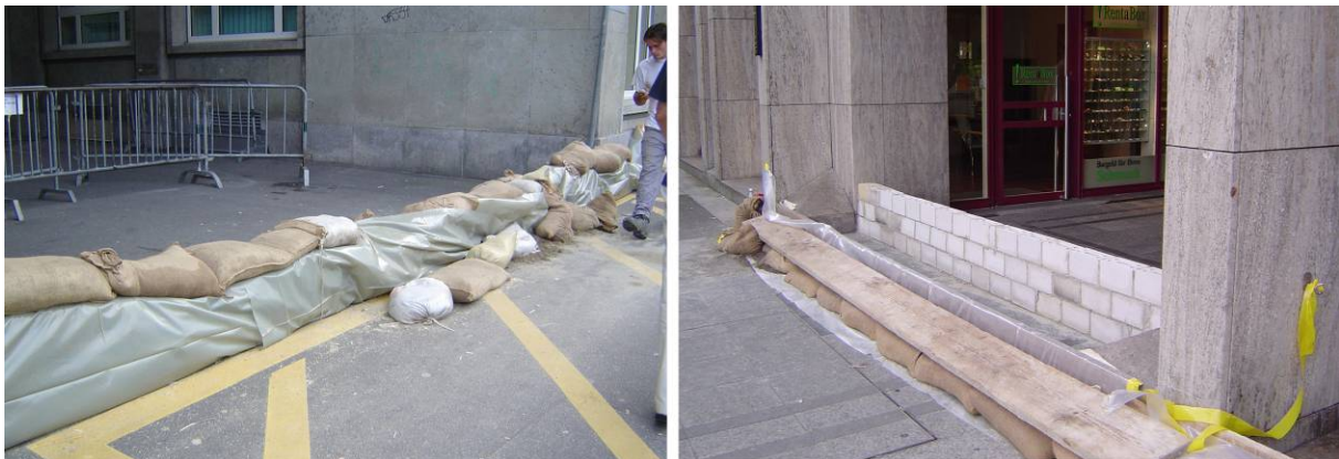
Abb. 5.18: Abdichtung von größeren Öffnungen mittels behelfsmäßiger Sofortmaßnahmen (Beispiele): (A) Abdichtung von Kellerfenstern mittels Sandsäcken; (B) Abdichtung mittels Stahlplatte und Sandsäcken (Quelle: BMLFUW); aus [13]
