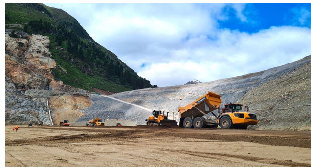
Oben: Gruppenfoto auf dem Hydraulikbagger Unten: Einbau der Erdkerndichtung
